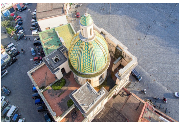
Stato di fatto : Vista dall'alto dell'edificio - degrado ed infiltrazioni dalle strutture esterne
