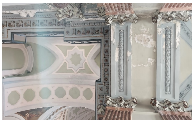
Stato di fatto : Vista dall'alto dell'edificio - degrado ed infiltrazioni dalle strutture esterne
